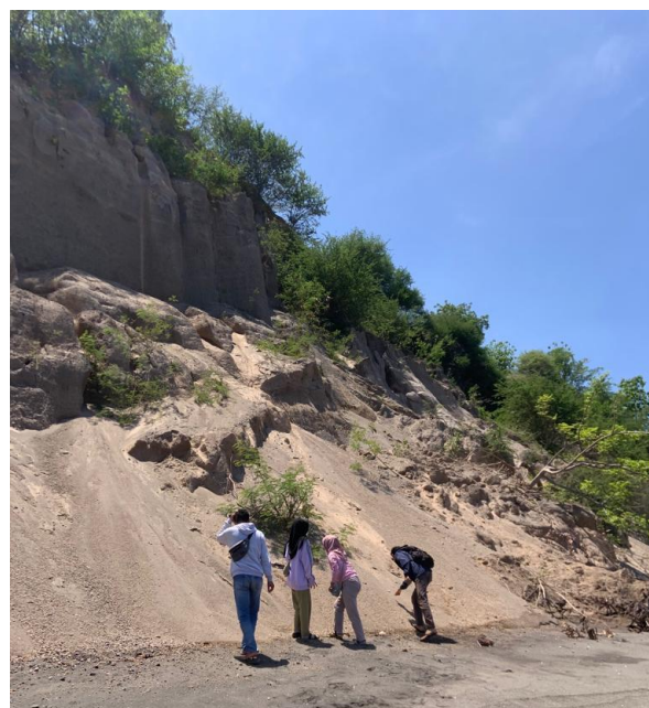
Gambar 8. Lokasi Longsoran Bukit
