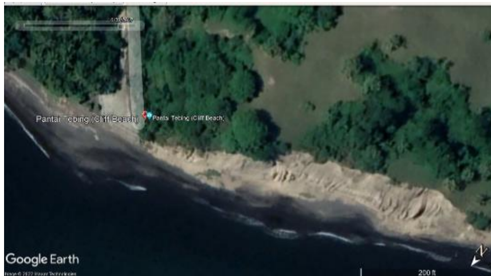
Gambar 3. Kondisi Bukit Tahun 2017 (Google Earth)
